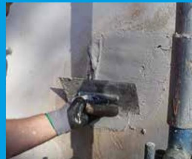
1. *Uništeni stari malter mora se temeljito ukloniti najmanje 1 metar iznad vidljive granice vlage, zatim se zid mora temeljito očistiti. Nakon toga obavezno s površine očistiti prašinu metlom ili usisavačem. Nikako ne koristiti vodu za čišćenje površine jer će to opet otopiti soli koje će naposljetku izbiti na površinu.*
