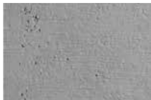
Tehnika grubog betona
