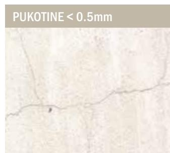
Čak i najtanje pukotine uže od 0,5 mm mogu uzrokovati trajno oštećenje strukture zgrade tokom vremena.
