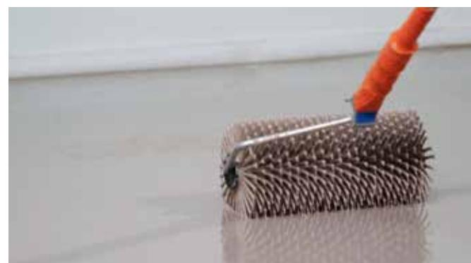
Svježe pripremljenu masu izliti na podlogu i ravnomjerno je rasporedite na željenu razinu. Zatim odzračite pomoću igličastog valjka. Pri ručnom postavljanju samonivelirajuće mase potrebno je izljevanje jednog tehnološkog polja izvršiti u roku od najviše 30 minuta. Preporučuje se korištenje minimalno 2 spremnika za miješanje - ovo ubrzava izvođenje radova i olakšava povezivanje samonivelirajuće mase.
