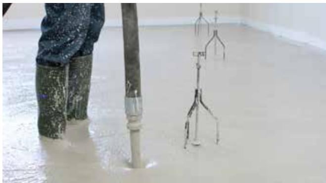
Vrijeme korištenja pripremljene mase na temp. od 20°C iznosi oko 30 minuta, pri čemu niže temperature produžuju, a više temperature skraćuju vrijeme korištenja.
